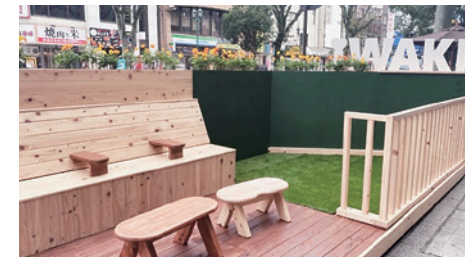
▲完成したパークレット
